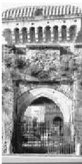
► Lifting alle Porte
